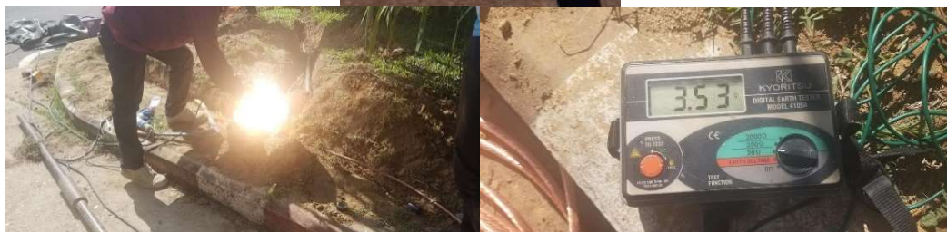
รูปภาพที่ ๒๗ ตรวจสอบการติดตั้งระบบกราดสายดิน ระบบป้องกันฟ้าผ่าและระบบป้องกันแรงดันไฟฟ้าสูงชั่วขณะ (SURGE)
