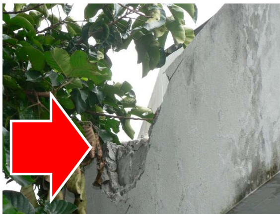
รูปภาพที่ ๑๒ ภาพผลกระทบจากกรณีฟ้าผ่าบริเวณอาคารผู้ป่วยใน รพ. หนองสูง
